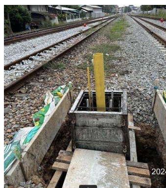
รูปที่ 1-3 งานขุดและติดตั้งเคเบิล (Cabling)
