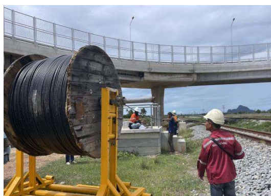
รูปที่ 1-3 งานขุดและติดตั้งเคเบิล (Cabling)
